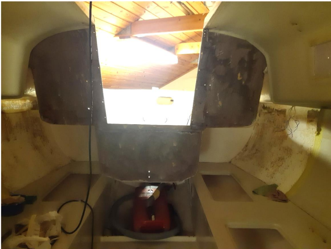
Renskräpad träinredning och borttagen plywood.
